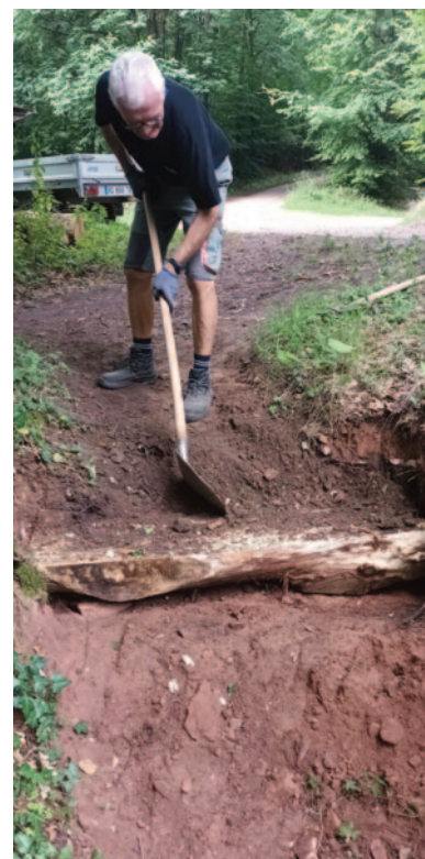
Réfection des marches à l'entrée du disque rouge en face du grand parking col du Pigeonnier.
